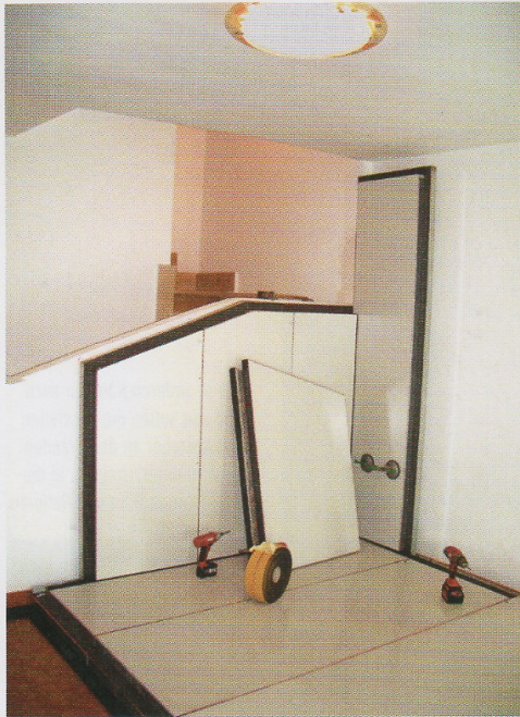
Extrem flexibel. Die Strukturpaneele bilden nicht nur Wand, Decke und Boden, sondern können dem Raum auch individuell angepasst werden.
